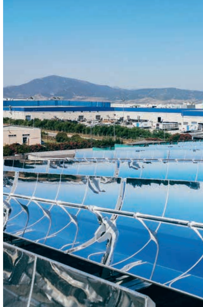
Die Solarpaneele in Izmir erzeugen Energie zum Kühlen und Heizen, pro Jahr für bis zu acht Monate.
